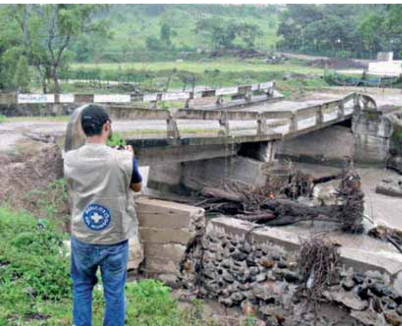
Puente de las aldeas El Jute y el Retablo, departamento de Casillas.
